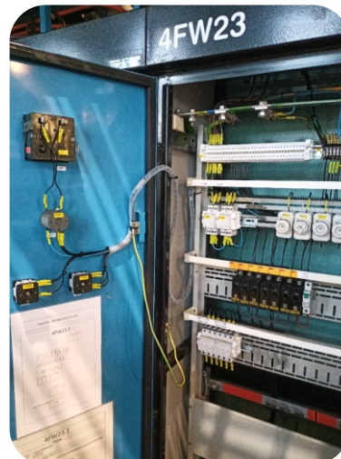
Rekonstrukce výbojkového osvětlení strojoven RB 1-4 v Elektrárně Dukovany
