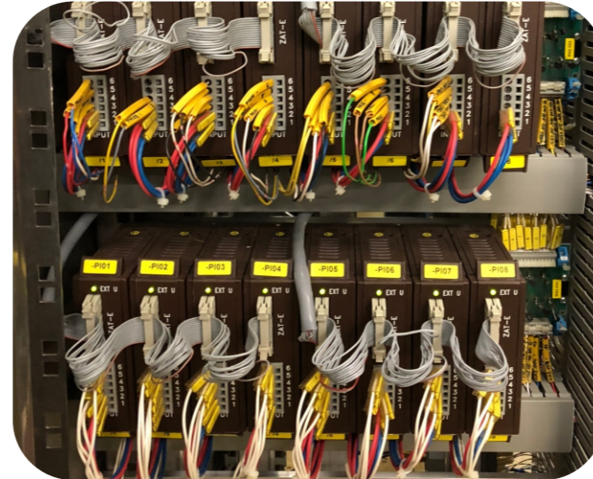
Obnova řídicího systému výrobního bloku B1 až B6 v Elektrárně Mělník
