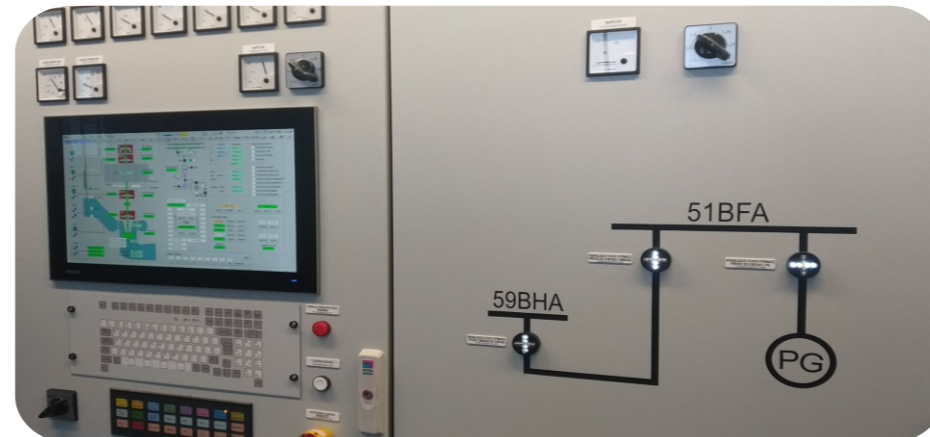
Rekonstrukce systému řízení kontrol, el. ochran, buzení generátorů, Elektrárna Slapy
